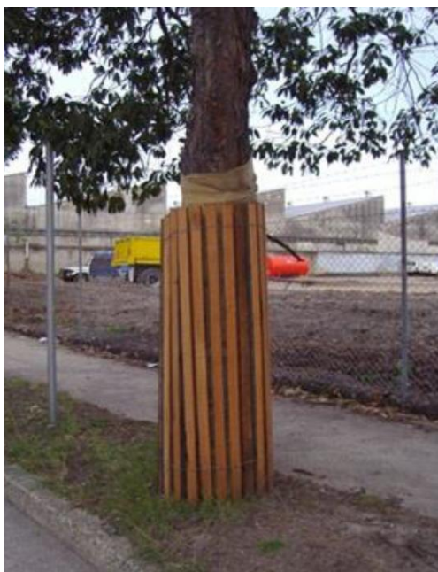
Rysunek 7 Przykład prawidłowego odeskowania drzewa podczas prac budowlanych
